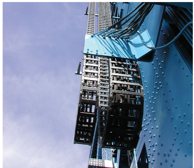
Nylatrac模块化TL拖链，阳极氧化铝横杆，在强风条件下增加强度，维持垂直升降桥上的电气和液压控制线路。图为：佛罗里达州杰克逊维尔的主街桥。
